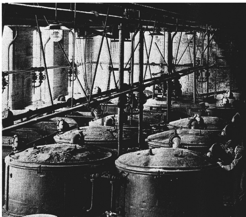
Kig ind i BASF's indigofabrik i Ludwigshafen, ca 1900. Produktionen foregår i store beholdere, der er forsynet med låg med inspektionsglas, hvorigennem kemikere kan holde øje med, om processen forløber, som den skal.
